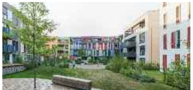
Grüner Innenhof in der Alten Weberei (Foto: Jammernegg)
