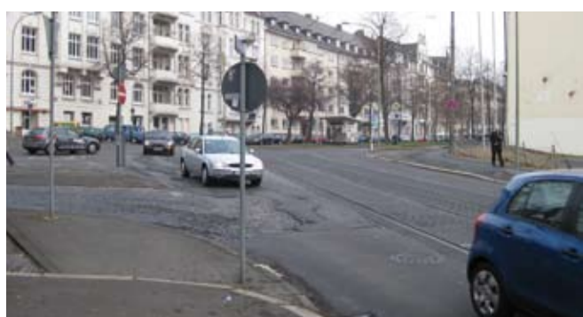
Unübersichtlich und städtebaulich unzureichend: Straßenraum im Kreuzungsbereich Goethe-, Germania-, Olga- und Reginastraße
